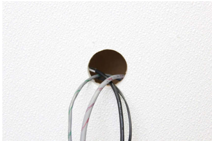
Figure 4 - Hole for TIU Wiring
